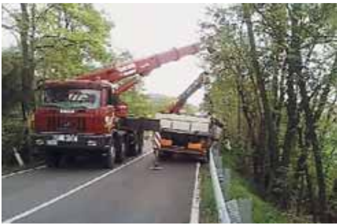
NIBBIANO - Le autogrù al lavoro per il recupero del camion
