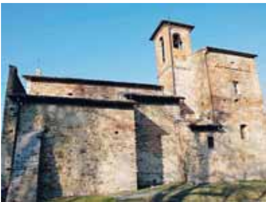
BRUSO di BORGONOVO - La chiesa priva di pluviali dopo il furto avvenuto all'inizio di febbraio: gli alpini, che hanno in cura la chiesa, hanno già avviato le procedure per rimpiazzarli (foto Grazioli)
