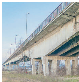
Il ponte sul Po di Pievetta
