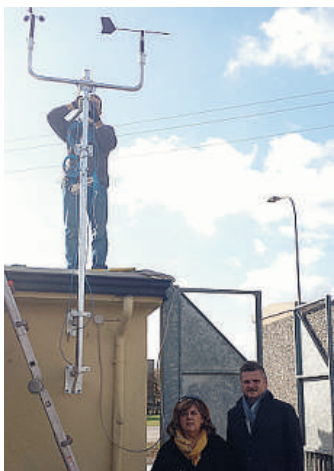
L'installazione della centralina
