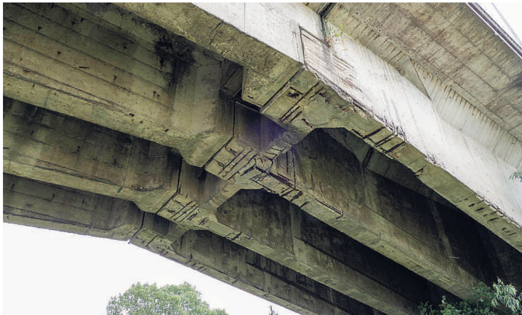
Uno dei punti critici del viadotto che collega Castelsangiovanni con la Lombardia
