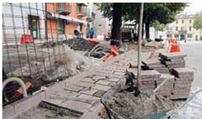
Al via i lavori di asfaltatura a Pianello e in parte delle strade delle frazioni (foto Bersani)
