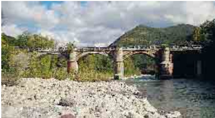
Anas ha aggiudicato la gara d'appalto per il consolidamento del ponte Lenzino
