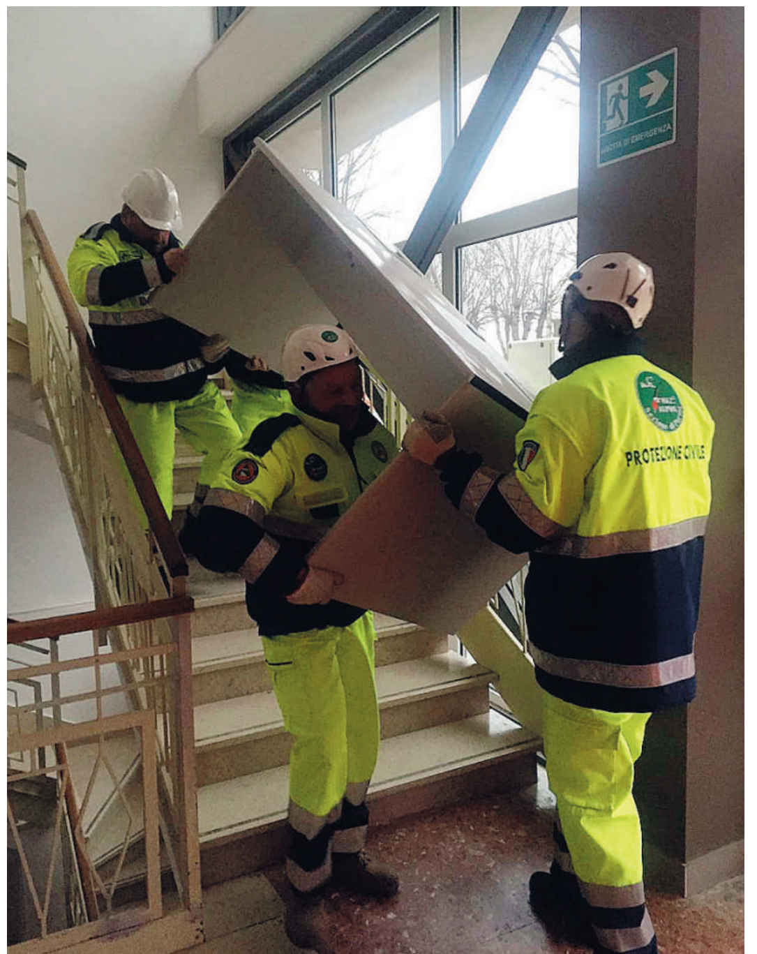
Armadi e tavoli recuperati dal secondo piano della scuola media. L'edificio non è agibile perché è a stretto contatto con la scuola elementare gravemente danneggiata dalla scossa del 30 ottobre scorso
