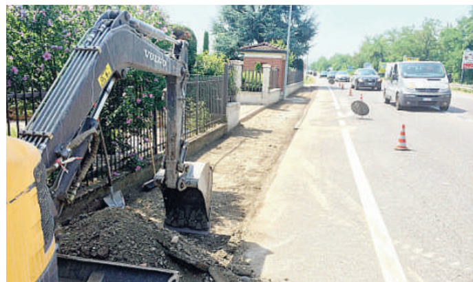
GOSSOLENGO - L'intervento di Anas lungo la Statale 45 a Quarto (f. Brusamonti)
