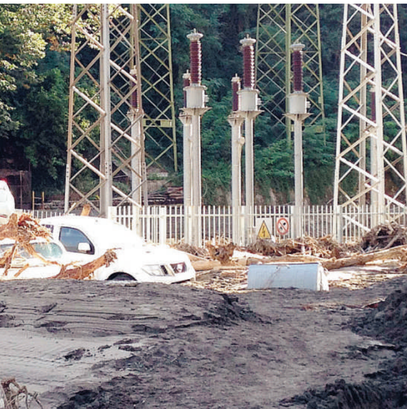
FERRIERE - Un'altra foto che dimostra lo stato di devastazione della centrale Ruffinatti
