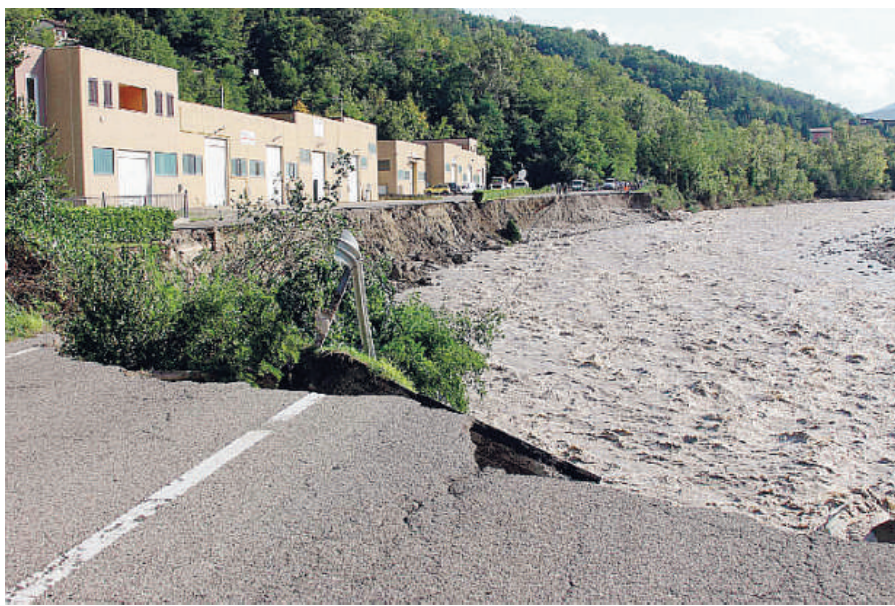
All'altezza di Recesio, il Nure in piena ha eroso la sponda e centinaia di metri di asfalto della strada provinciale; nella foto a destra il recupero della salma di Luigi Albertelli, la guardia giurata dell'Ivri travolta dal Nure (foto Marina e Libertà.it)
