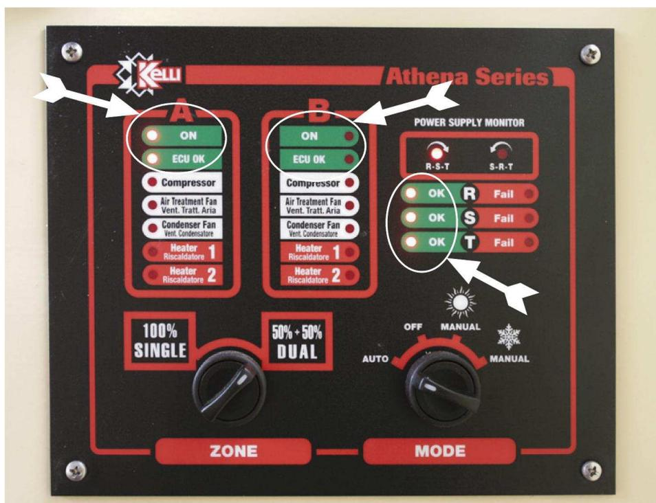
Se la qualità delle rete elettrica rientra nei parametri di funzionamento della macchina (3 LED OK accesi) il sistema è pronto per l'accensione altrimenti vengono segnalate sui relativi led eventuali anomalie elettriche ed il sistema non si avvierà. Verificare che i led ON siano illuminati ed i led ECU OK siano lampeggianti.
