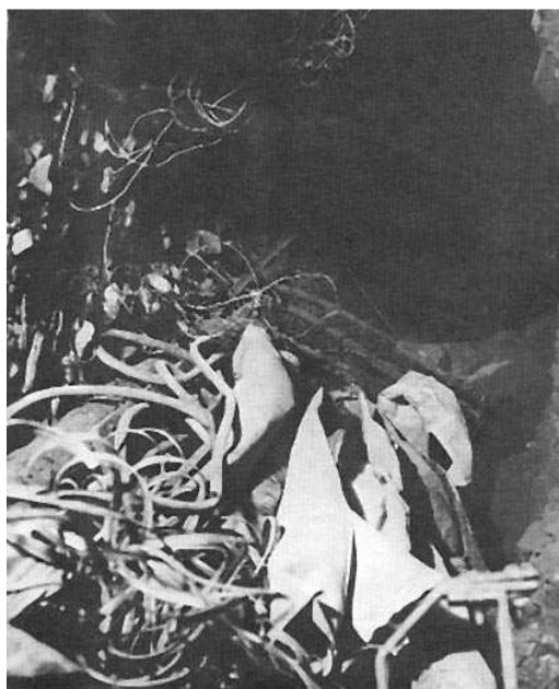
Dopo un'esplosione in galleria, i cavi telefonici, quelli dell'alta tensione e le tubature del sistema di rigenerazione dell'aria sono staccati dalle pareti e giacciono sul pavimento
